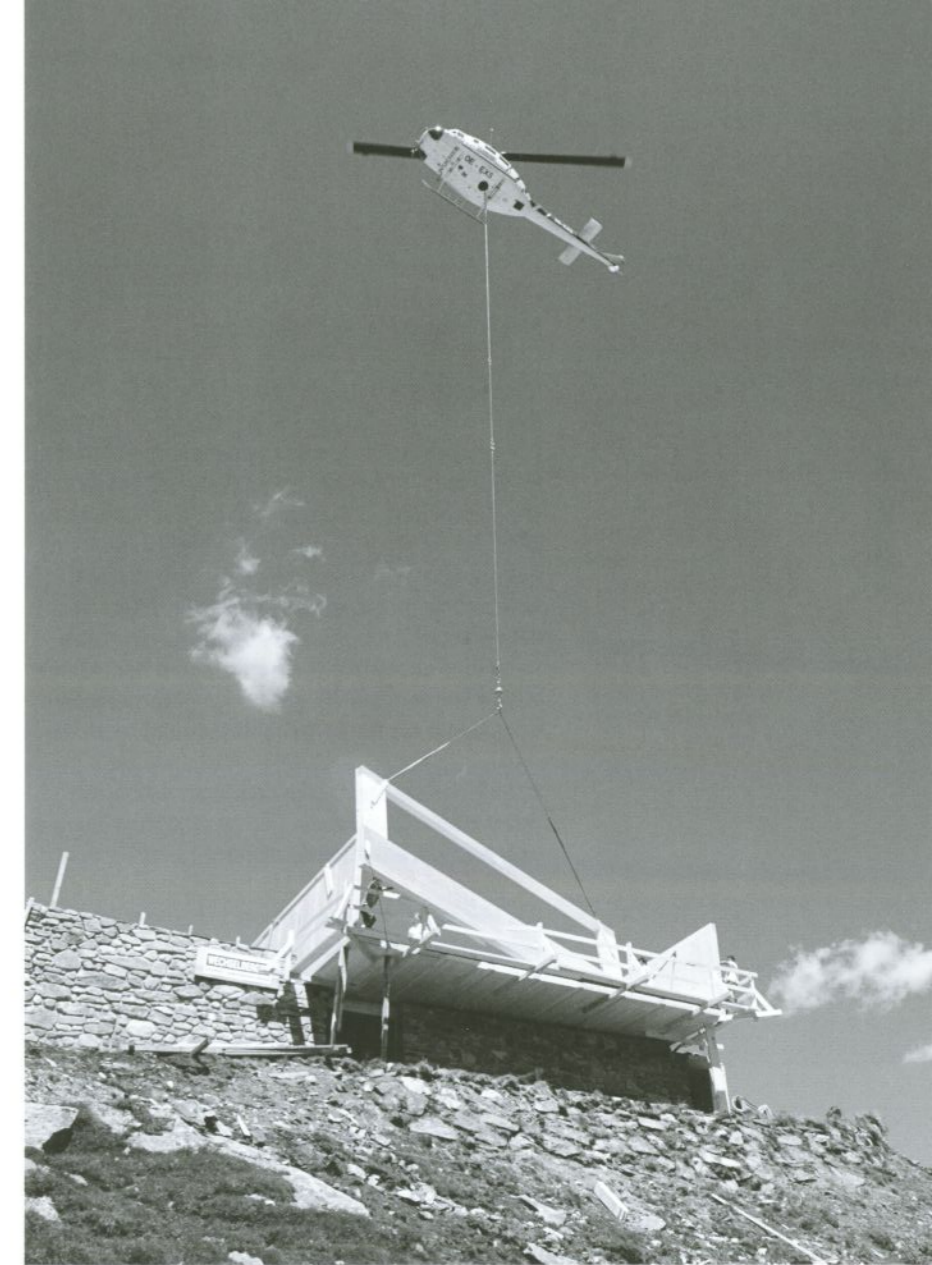
Zur Errichtung der Olperer Hütte waren 913 Hubschrauberflüge nötig.
